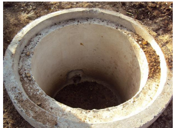
Figura 56 – Valas reaterradas com tubulação em PVC chegando aos PVs de inspeção em 24 ago. 2010 Fonte: Prefeitura Universitária do CDSA/UFCG
