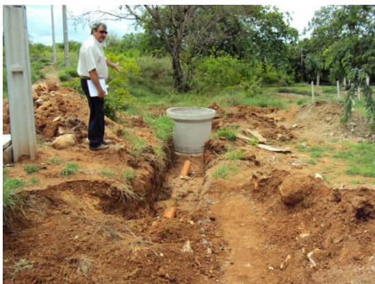
Figura 49 – Tubulação de esgoto e PV assentado sobre base de concreto em 11 jan. 2010 Fonte: Prefeitura Universitária do CDSA/UFCG
