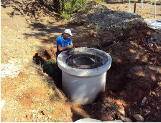
Figura 51 – Armação das ferragens para coroamento do PV em concreto armado em 06 mai. 2010 Fonte: Prefeitura Universitária do CDSA/UFCG
