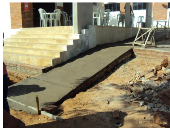
Figura 102 – Finalização da concretagem da passarela de acesso à Central de Aulas e ao Bloco de Cantina do Setor 2 do CDSA em 12 nov. 2010
