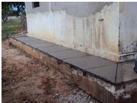
Figura 39 – Reconstrução do lastrado da calçada em 17 dez. 2010 Fonte: Prefeitura Universitária do CDSA/UFCG
