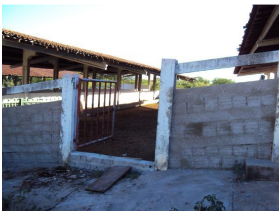
Figura 118 – Reconstrução e limpeza dos estábulos em 10 mar. 2010
