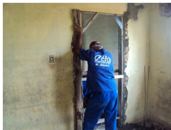
Figura 114 – Colocação de batente de porta em 10 dez. 2010
