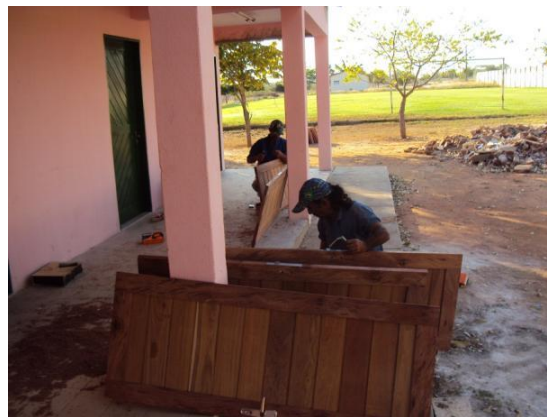
Figura 68 – Preparação para assentamento das portas internas dos Vestiários da Escola Agrícola em 04 out. 2010
