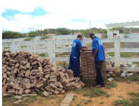
Figura 129 – Empilhamento de tijolos de argamassa de cimento (pavers) em 04 nov. 2010
