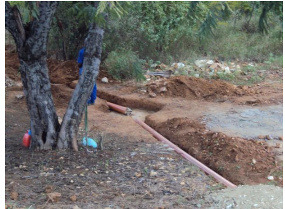
Figura 54 – Tubos de PVC assentados sobre valas escavadas em 10 jun. 2010 Fonte: Prefeitura Universitária do CDSA/UFCG
