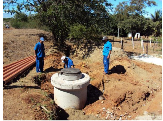
Figura 52 – PV com coroamento em concreto armado, com anel em concreto para colocação da tampa metálica em 12 mai. 2010 Fonte: Prefeitura Universitária do CDSA/UFCG
