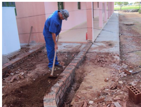
Figura 36 – Reaterro de caixão de calçadas entre o Laboratório Provisório de Química e o Bloco de Direção da Escola Agrícola em 20 set. 2010
