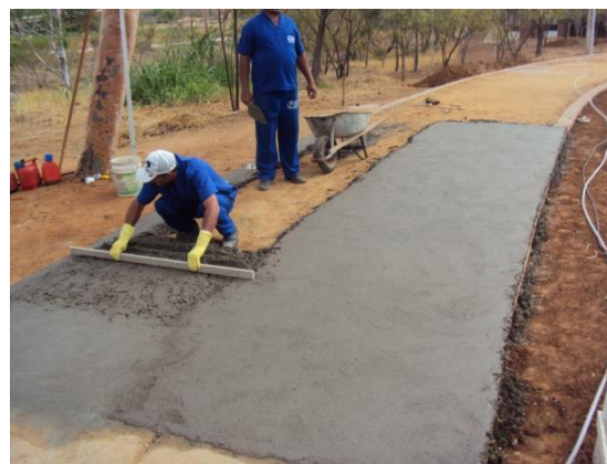
Figura 100 – Concretagem do lastro da calçada da passarela de acesso à Central de Aulas do Setor 2 do CDSA em 21 out. 2010
