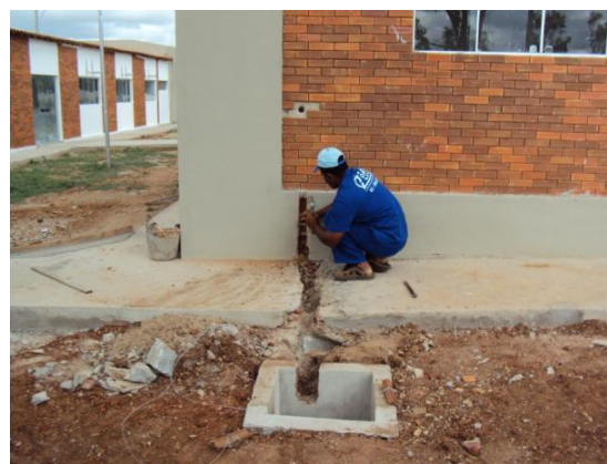
Figura 45 – Ligação da rede de lógica ao Bloco de Direção em 26 jan. 2010
