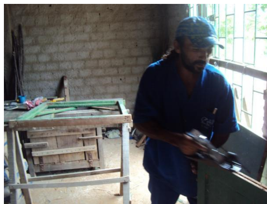
Figura 116 – Reforma de janela de madeira para posterior aproveitamento no edifício do Nupagro em 07 dez. 2010 Fonte: Prefeitura Universitária do CDSA/UFCG
