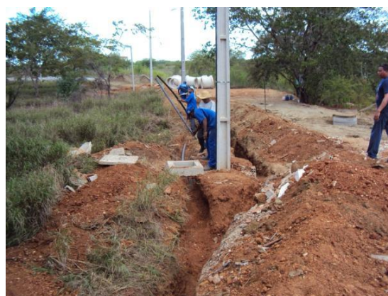
Figura 125 – Mudança de posicionamento da rede elétrica atrás do antigo capril em 10 jun. 2010 Fonte: Prefeitura Universitária do CDSA/UFCG
