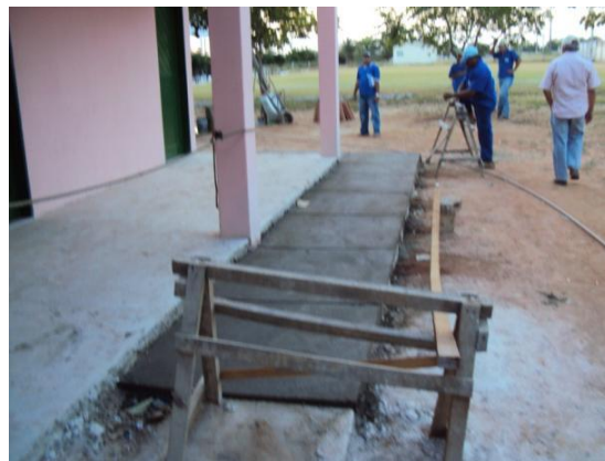
Figura 34 – Construção de calçadas no Bloco de Sala de Aulas da Escola Agrícola próximo ao Vestiário em 31 ago. 2010
