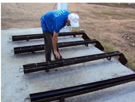
Figura 73 – Armação das ferragens para confecção das estacas em concreto pré-moldado para construção da cerca frontal do campus em 02 jun. 2010
