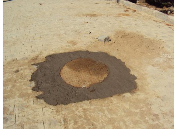
Figura 58 – PV de inspeção de esgoto devidamente acabado em 25 ago. 2010
