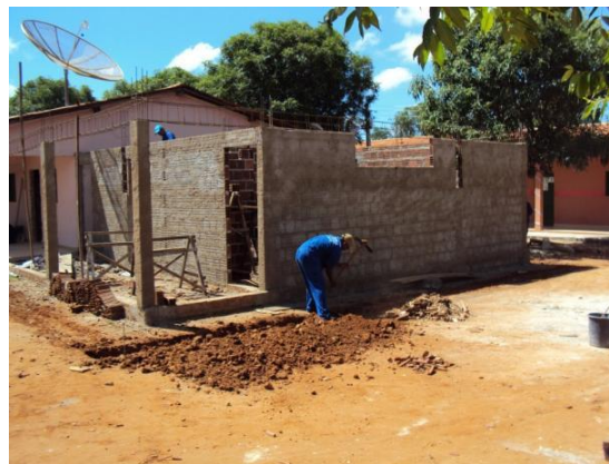
Figura 62 – Construção de vestiários da Escola Agrícola, ferragens das vigas posicionadas e início do chapisco externo em 18 fev. 2010
