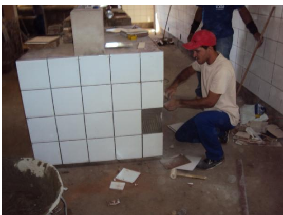
Figura 89 – Assentamento de revestimento cerâmico em bancada do Laboratório Provisório de Química em 13 ago. 2010
