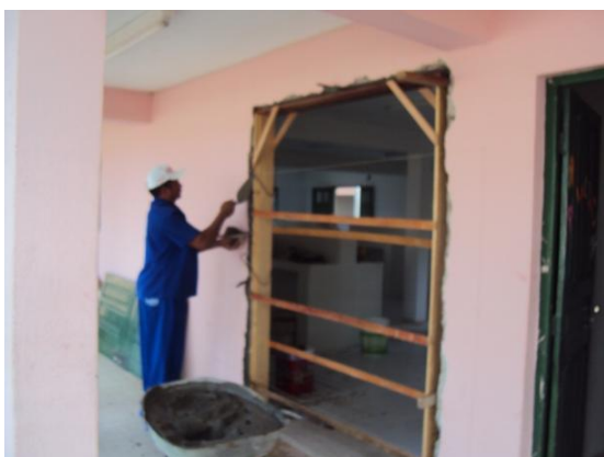
Figura 91 – Assentamento do batente de porta em madeira em duas folhas para acesso ao Laboratório Provisório de Química em 13 set. 2010
