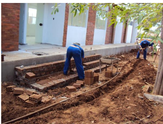
Figura 40 – Início da construção da escada e rampa de acesso ao Bloco de Biblioteca e Laboratório de Informática do Setor 2 do CDSA em 06 jan. 2010 Fonte: Prefeitura Universitária do CDSA/UFCG
