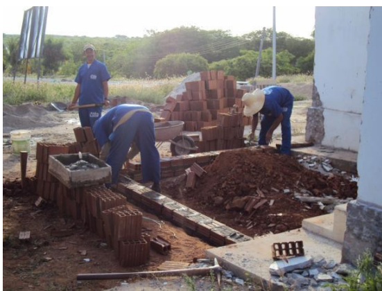
Figura 109 – Construção de alicerce em alvenaria dobrada com tijolos de 8 furos assentados com argamassa de cimento e massame em 22 nov. 2010
