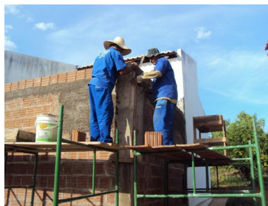
Figura 110 – Concretagem de elemento estrutural em 26 nov. 2010
