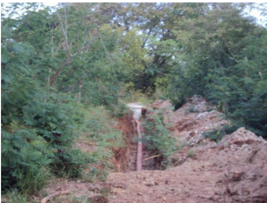
Figura 55 – Reaterro de valas após assentamento de tubo de esgoto em 27 jul. 2010 Fonte: Prefeitura Universitária do CDSA/UFCG
