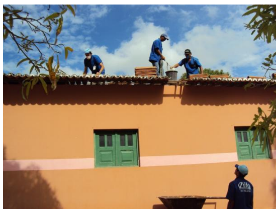
Figura 43 – Retelhamento da Escola Agrícola em 13 jan. 2010 Fonte: Prefeitura Universitária do CDSA/UFCG
