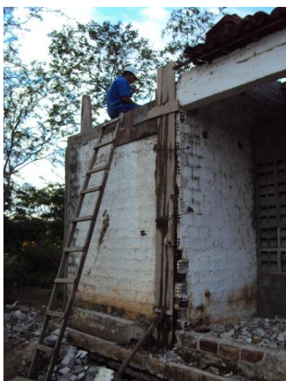
Figura 81 – Reparo estrutural necessário no antigo criatório de suínos para sediar o edifício do Espaço Estudantil em 15 jul. 2010
