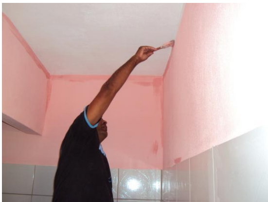
Figura 67 – Pintura interna dos Vestiários da Escola Agrícola em 12 jul. 2010
