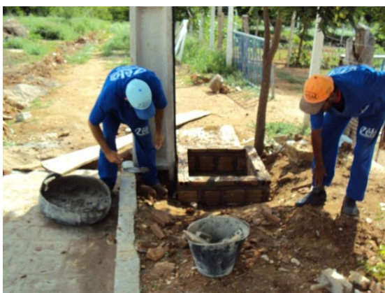
Figura 44 – Construção de caixa de instalações elétricas em frente ao Viveiro de Mudanças da Escola Agrícola em 20 jan. 2010
