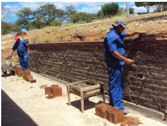
Figura 105 – Chapisco e assentamento de tijolos do muro de contenção em 01 dez. 2010
