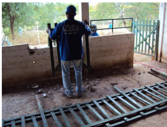
Figura 78 – Demolição de alvenaria e retirada de outros elementos construtivos em metal e madeira do antigo capril em 01 jun. 2010
