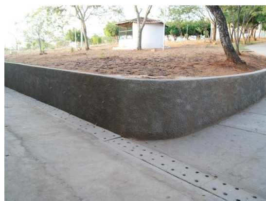
Figura 108-A – Muro de contenção finalizado
