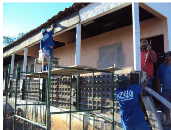
Figura 82 – Concretagem de peitoril e colunata da circulação do edifício do Espaço Estudantil com assentamento de elementos vazados e reboco externo em 29 jul. 2010
