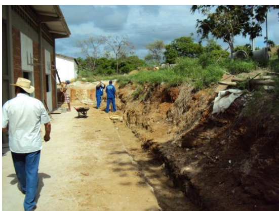
Figura 103 – Escavação de vala de drenagem em frente à Central de Aulas em 13 jan. 2010
