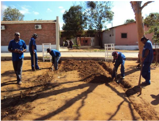
Figura 97 – Escavação manual para construção de alicerce de da passarela de acesso à Central de Aulas em 01 out. 2010
