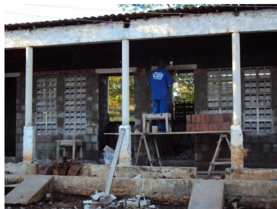
Figura 80 – Vergas de porta em concreto armado e elementos vazados em concreto aplicados no edifício do Espaço Estudantil em 22 jun. 2010
