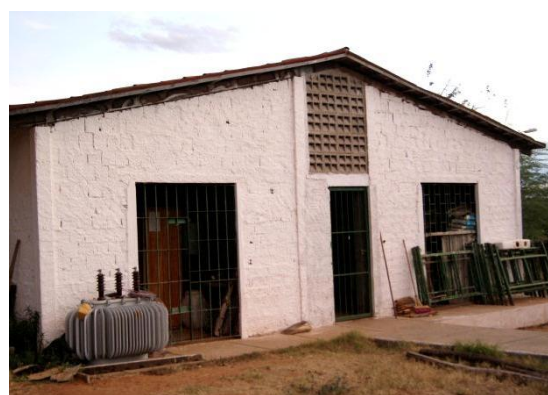
Figura 96-A – Almoxarifado da PUC finalizado
