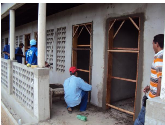
Figura 83 – Assentamento dos batentes de porta do edifício do Espaço Estudantil em 09 ago. 2010
