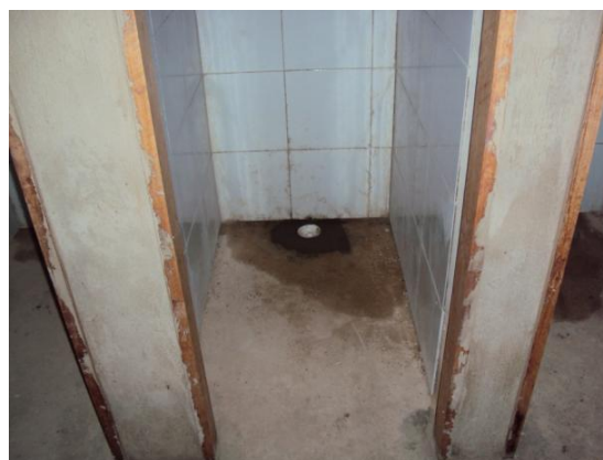
Figura 66 – Assentamento de cerâmica e construção do piso dos vestiários da Escola Agrícola em 09 jun. 2010
