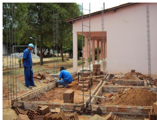
Figura 60 – Construção dos vestiários da Escola Agrícola, estágio de Unidação, radier em concreto armado e ferragens dos pilares em 03 fev. 2010 Fonte: Prefeitura Universitária do CDSA/UFCEG
