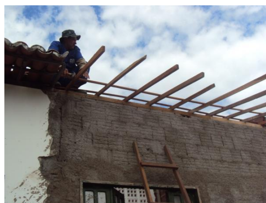
Figura 112 – Madeiramento para cobertura em telhas cerâmicas em 02 dez. 2010
