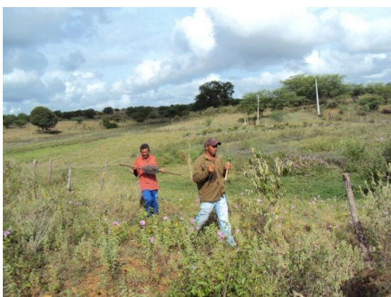
Figura 71 – Colocação de arame farpado nas estacas de madeira em 09 abr. 2010
