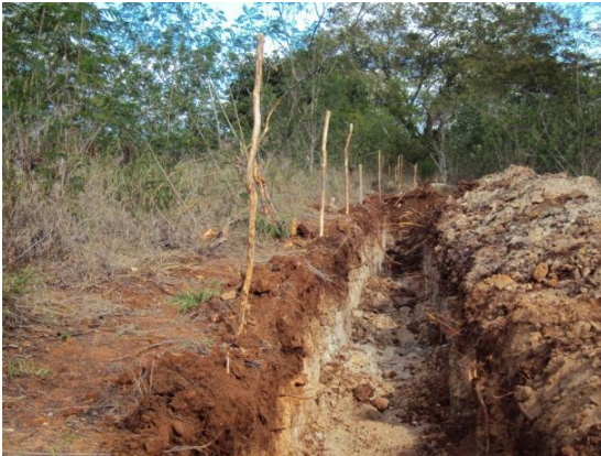
Figura 53 – Valas escavadas para até o último PV para assentamento de tubos de PVC em 10 jun. 2010 Fonte: Prefeitura Universitária do CDSA/UFCG
