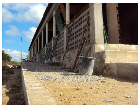
Figura 84 – Reaterro do caixão da rampa de acesso ao Espaço Estudantil para posterior concretagem do lastro em 11 ago. 2010
