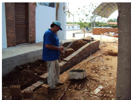
Figura 41 – Construção de rampa na lateral do Bloco de Biblioteca e Laboratório de Informática em 06 jan. 2010 Fonte: Prefeitura Universitária do CDSA/UFCG
