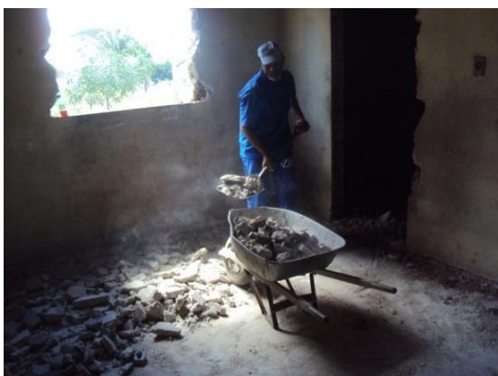
Figura 113 – Demolição e remoção de entulhos em 03 dez. 2010
