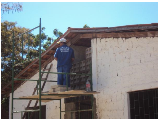
Figura 93 – Fechamento de abertura do almoxarifado da PUC com elementos vazados em concreto pré-moldado em 25 ago. 2010
