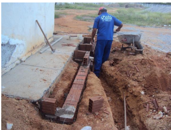
Figura 115 – Construção da jardineira em torno do edifício sede do Nupagro em 22 dez. 2010 Fonte: Prefeitura Universitária do CDSA/UFCG
