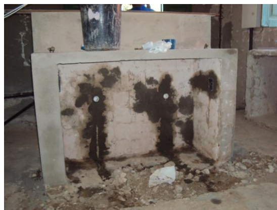
Figura 88 – Tubulação hidrossanitária e elétrica devidamente assentada em 29 jul. 2010
