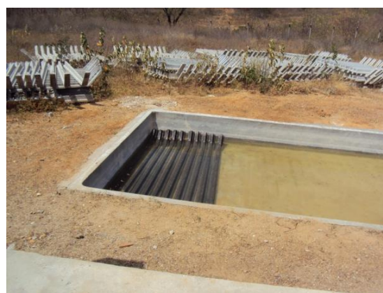
Figura 74 – Colocação das estacas de concreto pré-moldado em tanque com água para cura do concreto em 15 out. 2010
