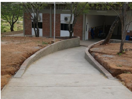
Figura 101 – Calçada da passarela de acesso à Central de Aulas do Setor 2 do CDSA em 03 dez. 2010
