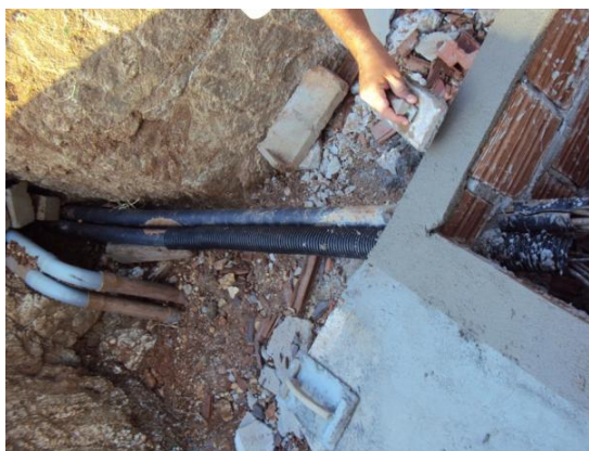
Figura 48 – Construção de caixa de inspeção de energia elétrica em frente à Central de Aulas do Setor 2 do CDSA em 28 set. 2010 Fonte: Prefeitura Universitária do CDSA/UFCG
