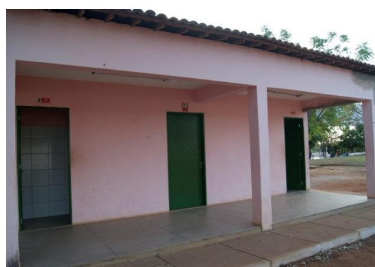
Figura 70-A – Pintura de porta interna dos Vestiários da Escola Agrícola em 05 out. 2010
