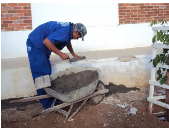
Figura 37 – Reparo na calçada do Bloco das Coordenações do Setor 2 do CDSA em 22 nov. 2010
