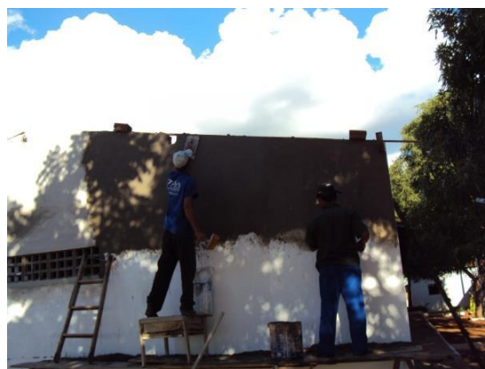
Figura 64 – Reboco e pintura da fachada norte dos vestiários da Escola Agrícola em 03 mai. 2010
