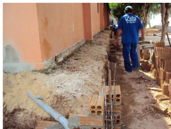
Figura 32 – Reforma de calçadas com complemento de alvenaria de tijolos cerâmicos em 08 fev. 2010
