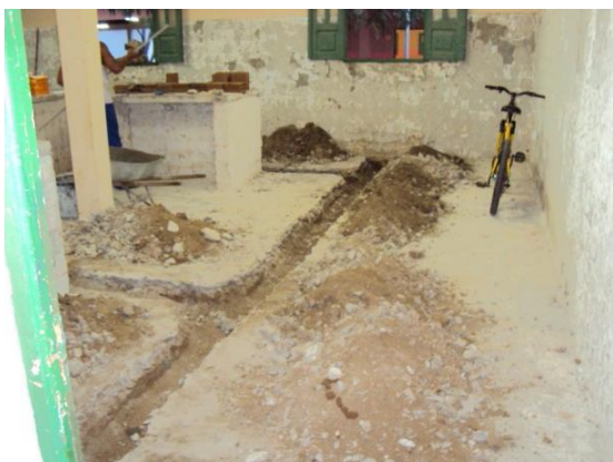
Figura 87 – Laboratório Provisório de Química com valas escavadas no piso e revestimento cerâmico demolido em 15 jul. 2010
