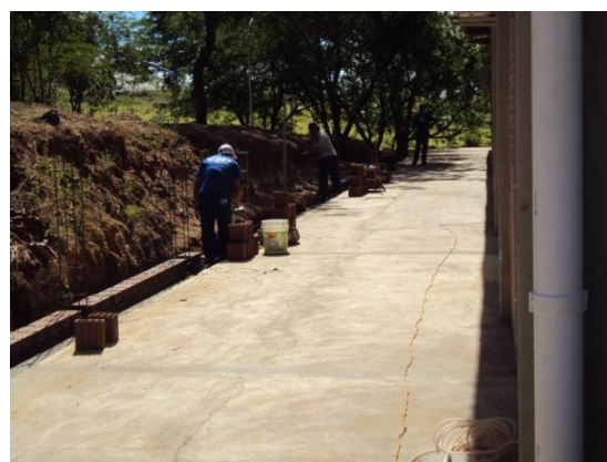
Figura 104 – Ferragens dos pilares posicionados e construção de alvenaria dobrada do muro de contenção em frente à Central de Aulas do Setor 2 do CDSA em 18 nov. 2010
