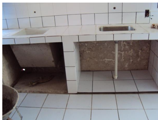
Figura 90 – Balcão do Laboratório Provisório de Química antes do rejuntamento do revestimento cerâmico em 01 set. 2010
