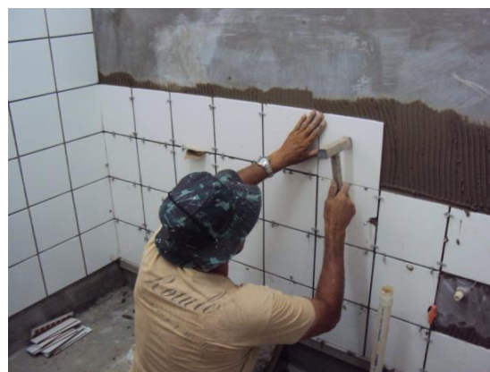
Figura 76 – Assentamento de revestimento cerâmico no banheiro da PUC em 05 out. 2010
