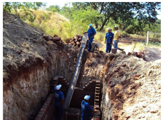
Figura 50 – Construção de fossa séptica provisória do CDSA em 09 mar. 2010 Fonte: Prefeitura Universitária do CDSA/UFCG
