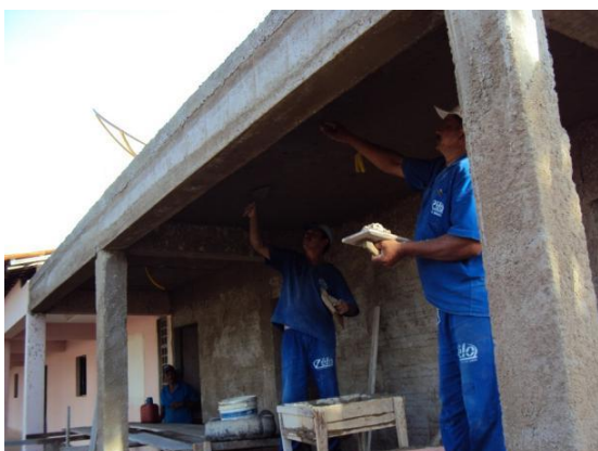
Figura 63 – Execução do reboco no teto dos vestiários da Escola Agrícola em 08 abr. 2010
