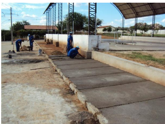
Figura 31 – Concretagem de lastro de calçada da quadra poliesportiva em 06 jan. 2010
