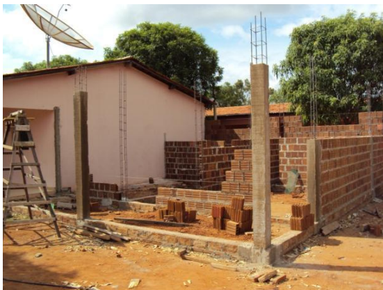
Figura 61 – Construção de vestiários da Escola Agrícola, pilares concretados e iniciada a alvenaria de vedação em 08 fev. 2010
