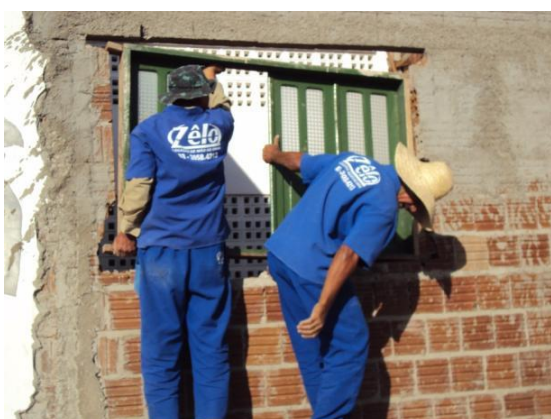
Figura 111 – Assentamento de esquadrias em 30 nov. 2010
