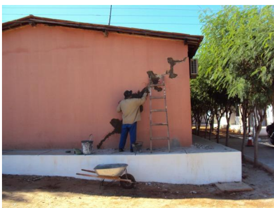
Figura 124 – Reparo estrutural em alvenaria do Bloco de Salas de Aulas da Escola Agrícola em 11 mai. 2010 Fonte: Prefeitura Universitária do CDSA/UFCG
