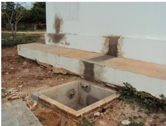
Figura 46 – Caixa de inspeção de ligação da rede de telefonia e lógica ao bloco da Prefeitura Universitária do Setor 2 do CDSA em 03 fev. 2010 Fonte: Prefeitura Universitária do CDSA/UFCG
