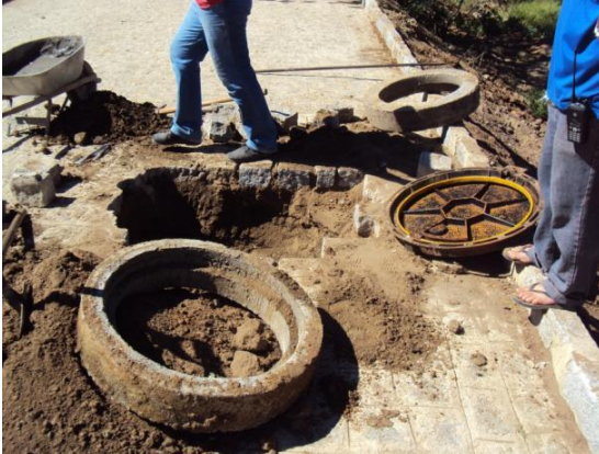
Figura 57 – Colocação de anéis de concreto em PV de inspeção para elevar o nível altimétrico da tampa metálica em 25 ago. 2010
