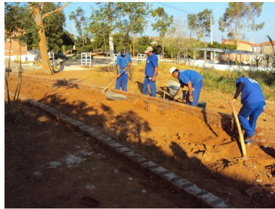
Figura 98 – Reaterro do caixão da passarela de acesso à Central de Aulas do Setor 2 do CDSA em 05 out. 2010
