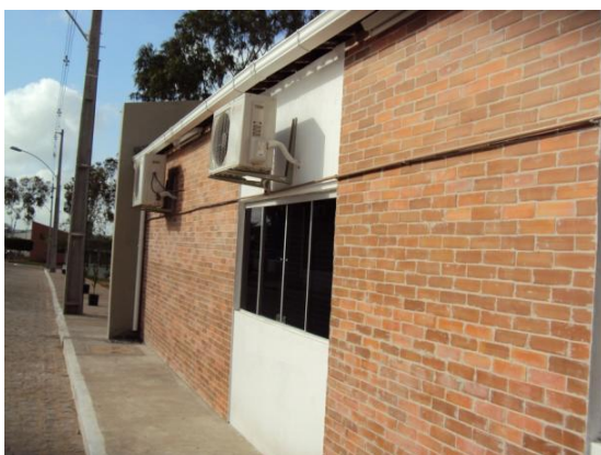
Figura 122 – Canalização de drenagem dos aparelhos de ar-condicionado do Bloco de Biblioteca e Laboratório de Informática em 08 abr. 2010 Fonte: Prefeitura Universitária do CDSA/UFCG
