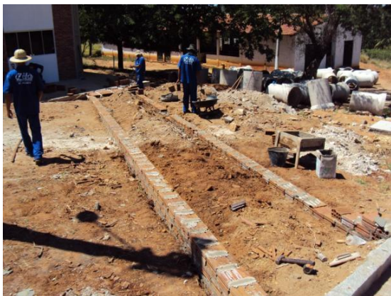
Figura 33 – Construção de calçada de acesso à Central de Aulas em 03 mar. 2010
