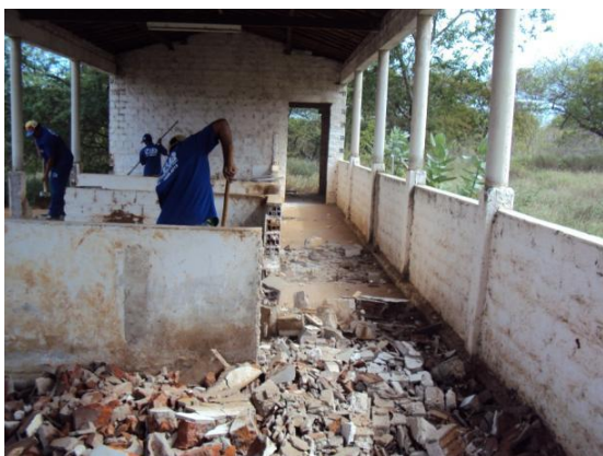
Figura 79 – Demolição de alvenaria do antigo criatório de suínos em 14 jun. 2010
