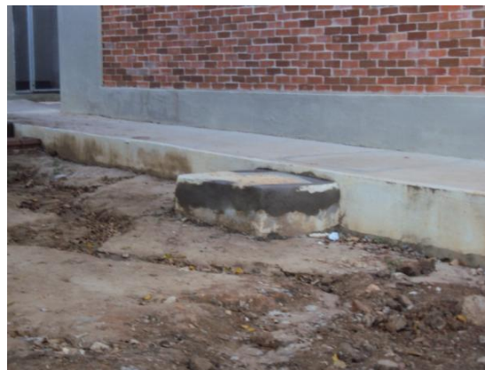
Figura 47 – Reparo em caixa de inspeção de esgoto atrás do Bloco de Cantina em 24 ago. 2010 Fonte: Prefeitura Universitária do CDSA/UFCG
