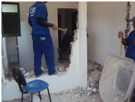
Figura 77 – Demolição de alvenaria da sala de recepção da PUC em 11 out. 2010
