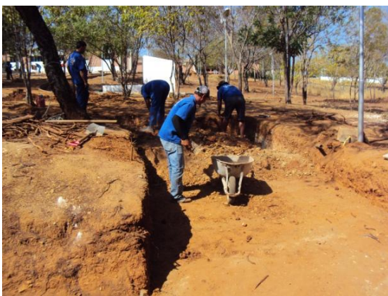
Figura 99 – Escavação manual para rebaixamento do nível da passarela próximo à Central de Aulas em 18 out. 2010
