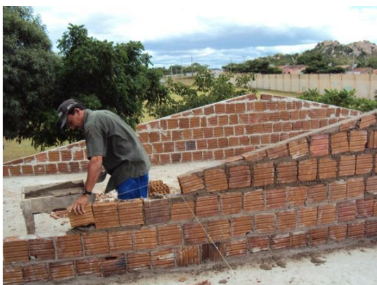
Figura 65 – Construção das empenas da cobertura dos vestiários da Escola Agrícola em 04 mai. 2010
