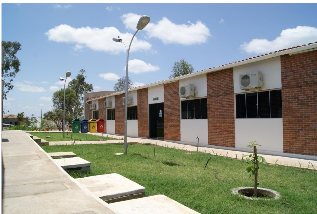
Figura 158-D – Prédio das coordenações administrativas – UAEDUC e UATEC. Fonte: NJC/CDSA/UFCG
