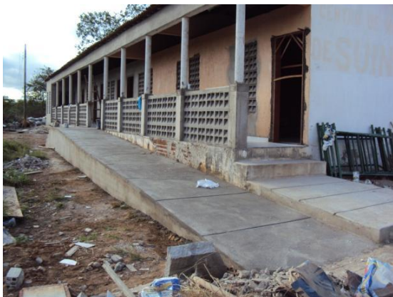
Figura 85 – Lastro da rampa de acesso do Espaço Estudantil devidamente concretado em 18 ago. 2010 Fonte: Prefeitura Universitária do CDSA/UFCG
