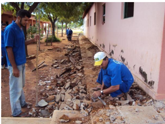
Figura 35 – Demolição de calçadas de um dos Blocos de Salas de Aula da Escola Agrícola em 01 set. 2010
