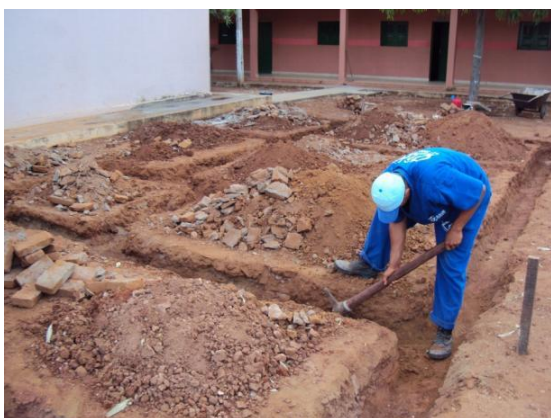
Figura 59 – Escavação para construção do alicerce dos vestiários da Escola Agrícola em 26 jan. 2010 Fonte: Prefeitura Universitária do CDSA/UFCEG
