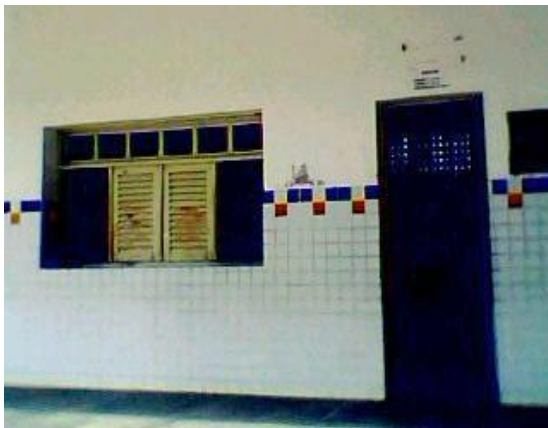
Figura 133 – Entrada da sala de aula da EEEFM Prof. José Gonçalves de Queiroz cedida como Sala de Leitura Fonte: Biblioteca Setorial do CDSA/UFCG
