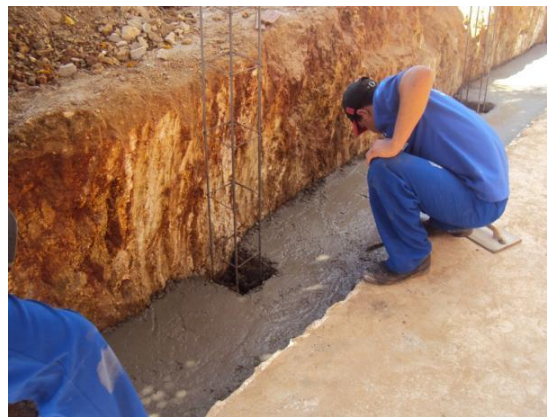
Figura 106 – Concretagem da fundação do muro de contenção na área oeste da Central de Aulas em 06 dez. 2010
