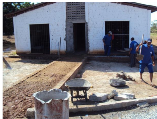
Figura 94 – Alicerce de calçada com caixão reaterado e compactado em 01 out. 2010
