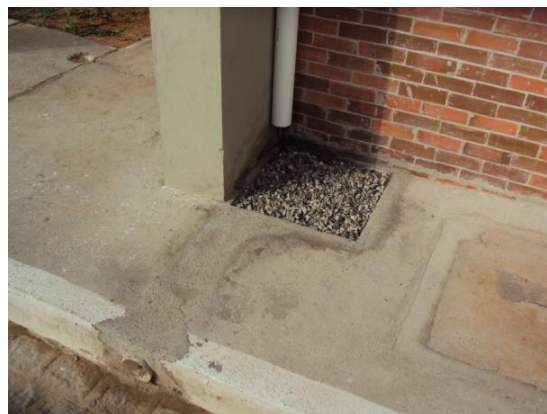
Figura 121 – Caixa de brita coletora de águas do Bloco de Biblioteca e Laboratório de Informática em 08 abr. 2010 Fonte: Prefeitura Universitária do CDSA/UFCG
