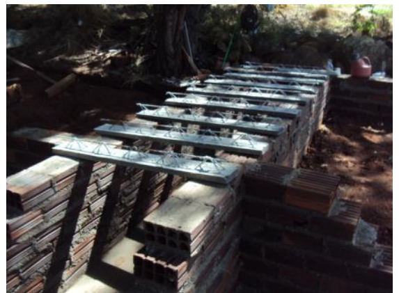
Figura 44: Assentamento de vergas para laje da passagem molhada
