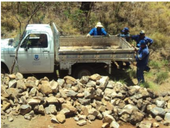
Figura 137: uso de pedras rachão para a construção do muro de arrimo
