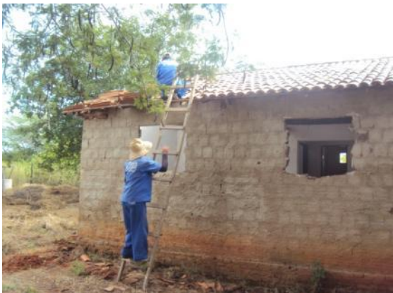
Figura 75: Reforma de edifício existente no local
