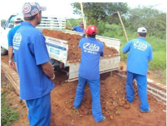
Figura 45: Reaterro do caixão
