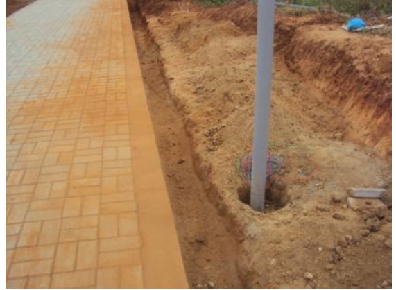
Figura 111: Trabalho de instalações elétricas
