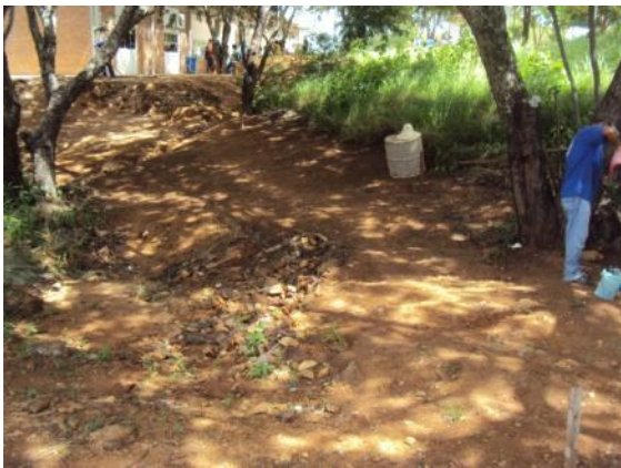
Figura 41: Limpeza do terreno
