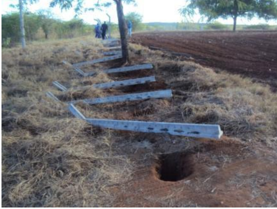
Figura 85: assentamento de estacas de concreto para construção de cerca
