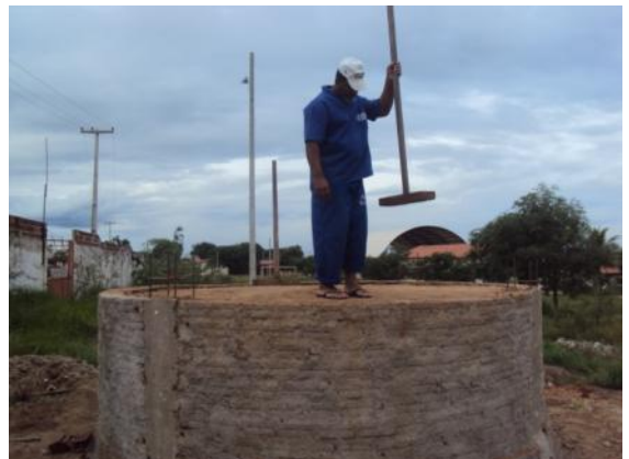
Figura 95: Compactação de material de reaterro do caixão
