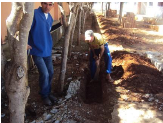
Figura 65: Escavação para construção de alicerce
