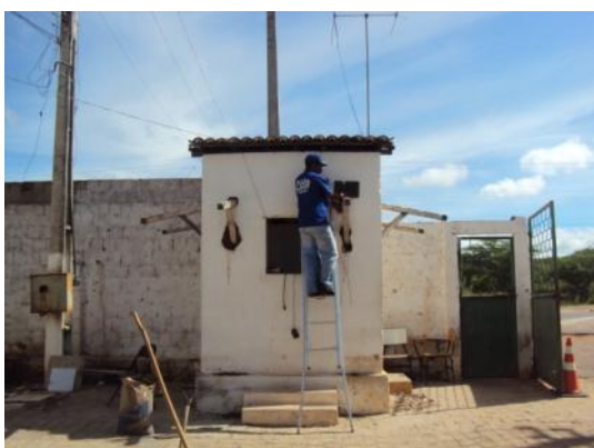
Figura 1: Preparação para assentamento de estrutura de madeira
