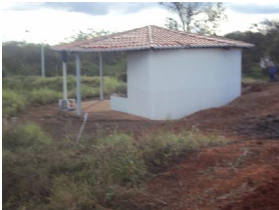
Figura 114: Limpeza do terreno
