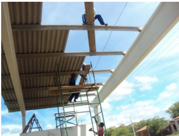
Figura 4: Assentamento de telhas de fibrocimento
