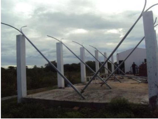
Figura 110: Pintura dos postes de aço para iluminação
