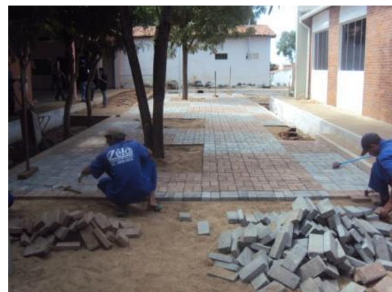
Figura 70: Assentamento de blocos intertravados PAVERS
