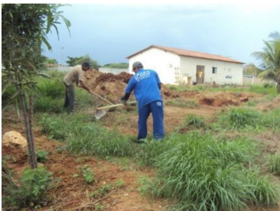
Figura 55: Limpeza do terreno
