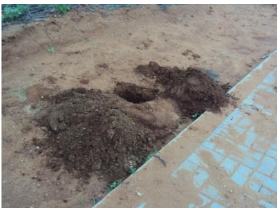
Figura 108: Escavação para assentamento de postes
