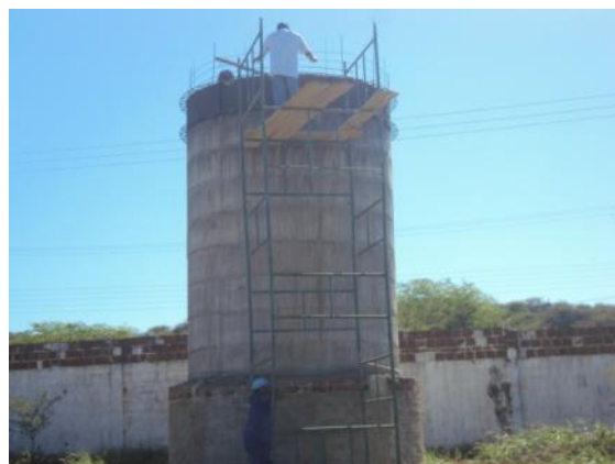
Figura 101: Concretagem do reservatório de água
