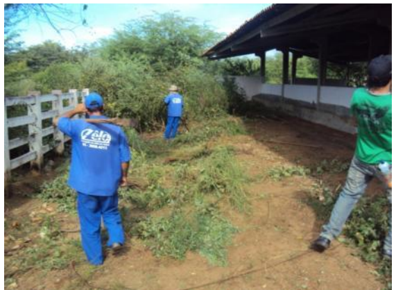
Figura 50: Remoção de vegetação e entulho com pessoal da empresa Zêlo
