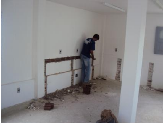
Figura 19: Quebra da alvenaria para construção de bancadas
