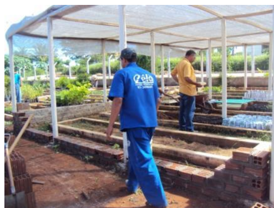
Figura 26: Instalação da tela
