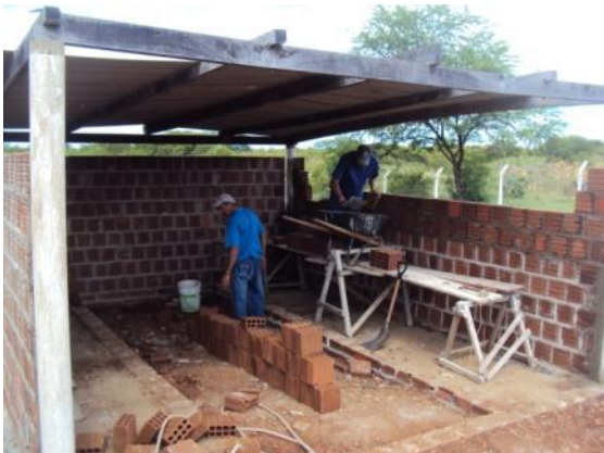
Figura 53: Construção de minhocário em alvenaria de tijolos cerâmicos
