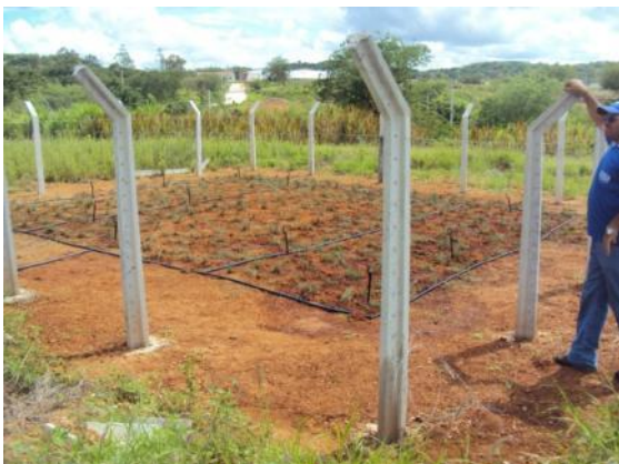
Figura 61: Estacas assentadas para fixação do telado
