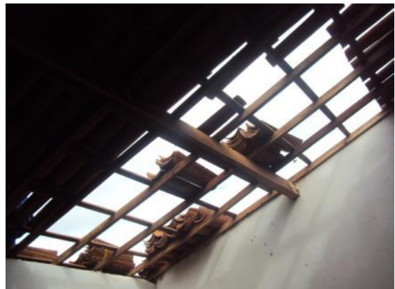
Figura 76: Retelhamento de edifício existente no local
