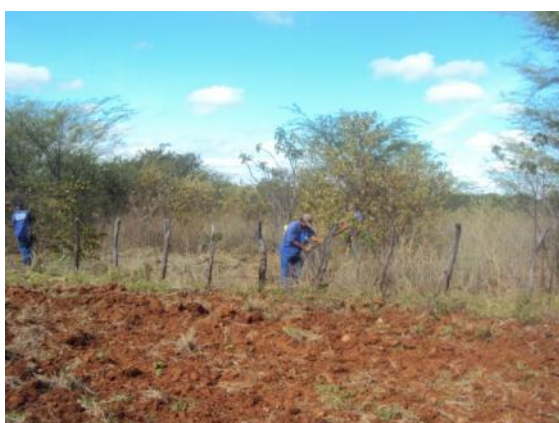
Figura 119: Reforma de cerca existente
