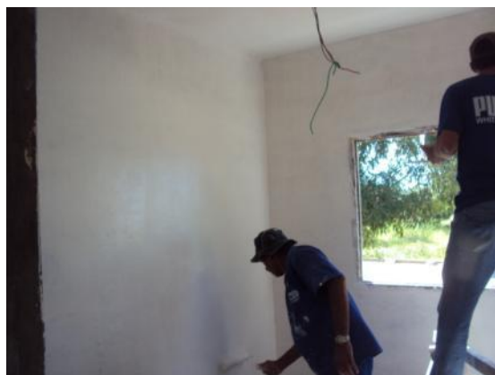
Figura 35: Trabalhos de pintura
