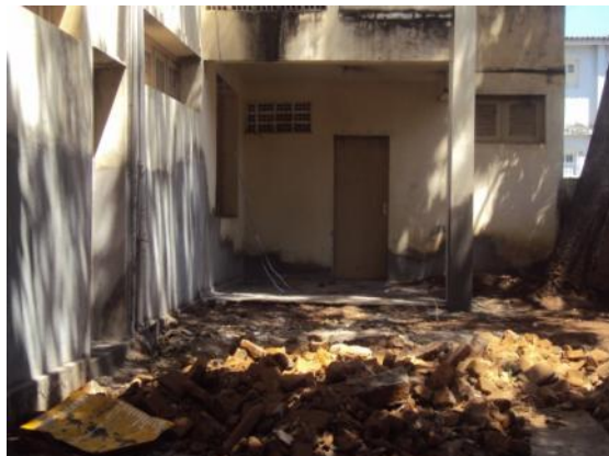
Figura 127: Remoção de entulhos
