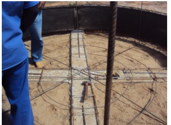
Figura 97: Armação de ferragens para concretagem do reservatório de água
