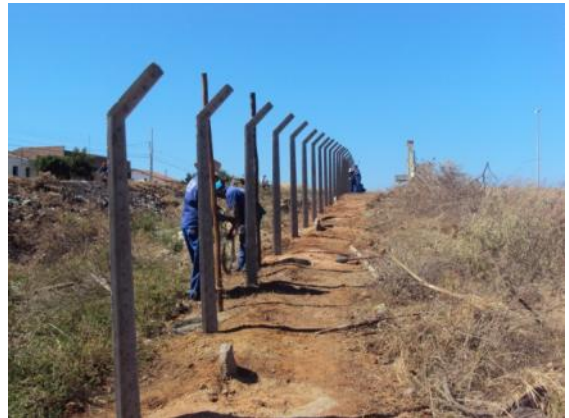
Figura 122: Assentamento de estacas de concreto
