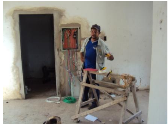
Figura 16: Trabalhos de instalações elétricas
