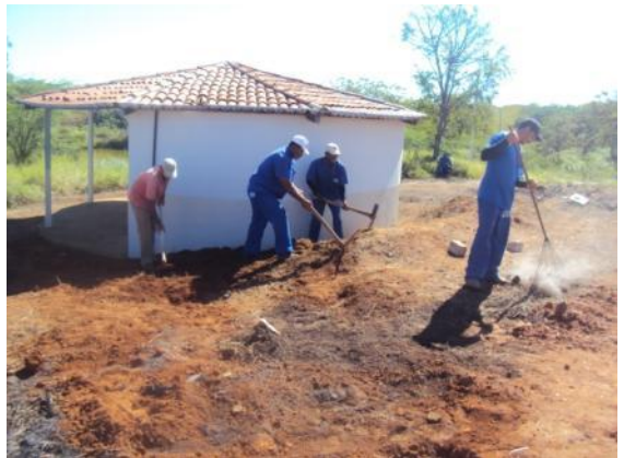
Figura 115: Limpeza do terreno
