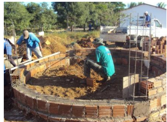
Figura 93: Alvenaria em tijolos cerâmicos
