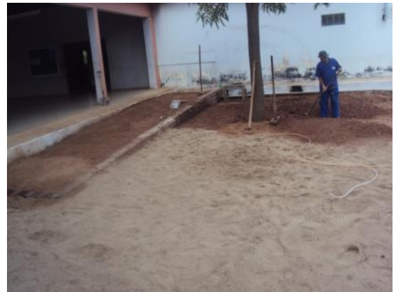
Figura 68: Colchão de areia para assentamento dos PAVERS
