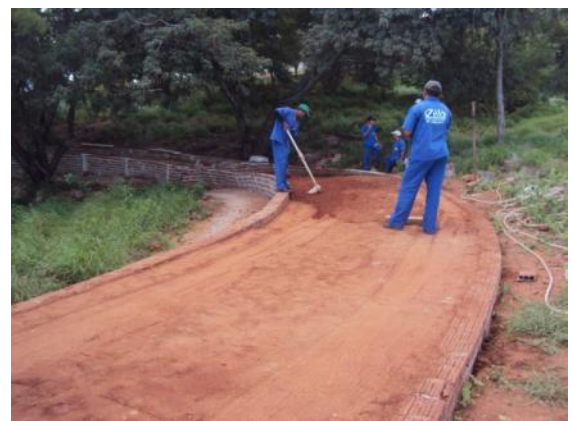
Figura 46: Compactação do material de aterro
