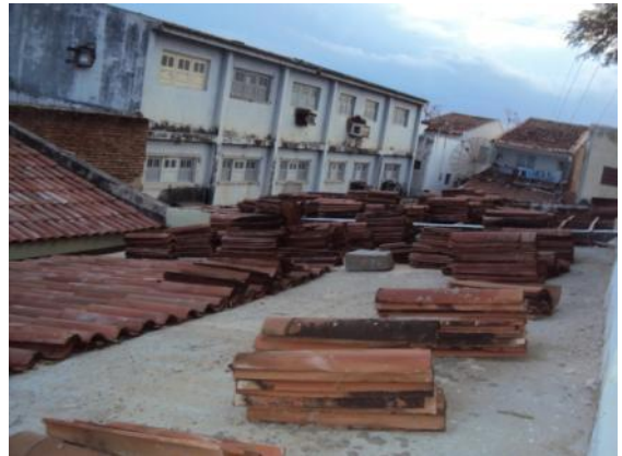
Figura 133: Retelhamento da cobertura
