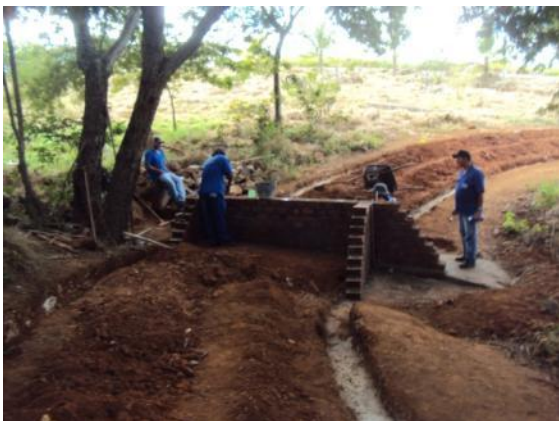
Figura 43: Construção de alicerce e passagem molhada
