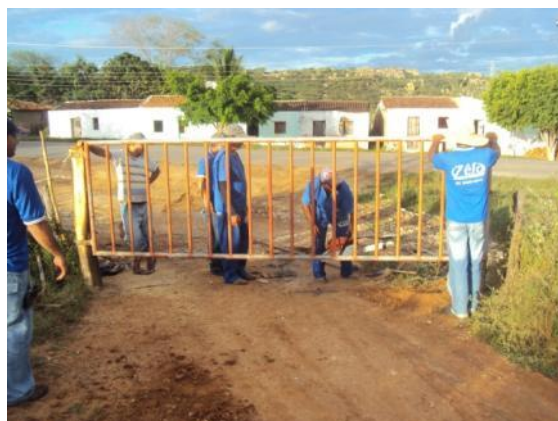
Figura 118: Fixação de portão metálico em cerca do campus
