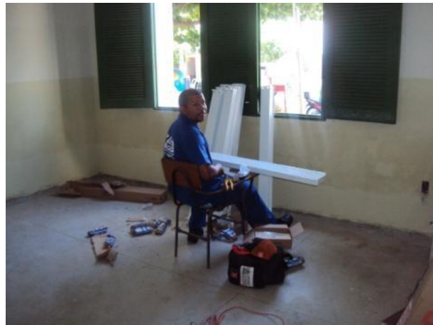
Figura 134: Trabalhos de instalações elétricas
