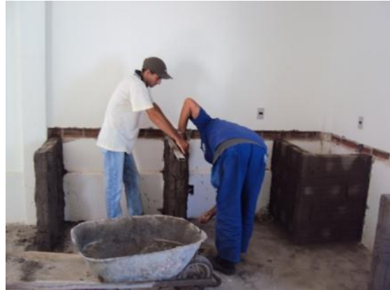
Figura 20: Construção de base em alvenaria para apoio dos balcões de concreto
