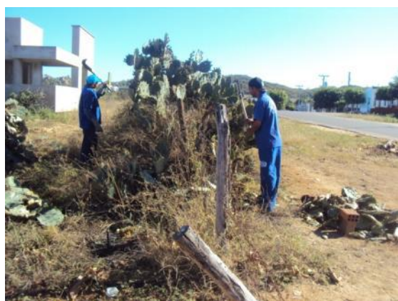
Figura 120: Remoção de cerca antiga
