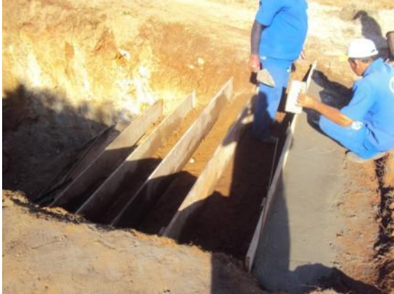
Figura 57: Construção de escada em concreto
