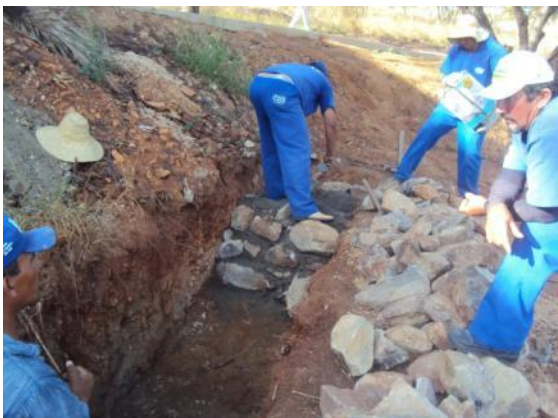
Figura 139: Construção do alicerce com pedras rachão e argamassa de cimento
