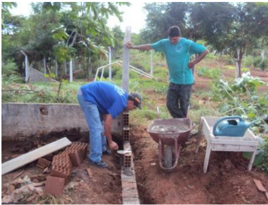
Figura 90: Levantamento de alvenaria de tijolos cerâmicos
