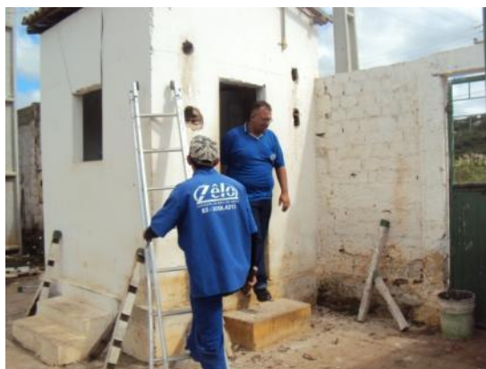
Figura 2: Assentamento da estrutura de madeira
