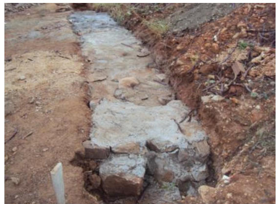
Figura 140: Alicerce do muro de arrimo parcialmente concluído
