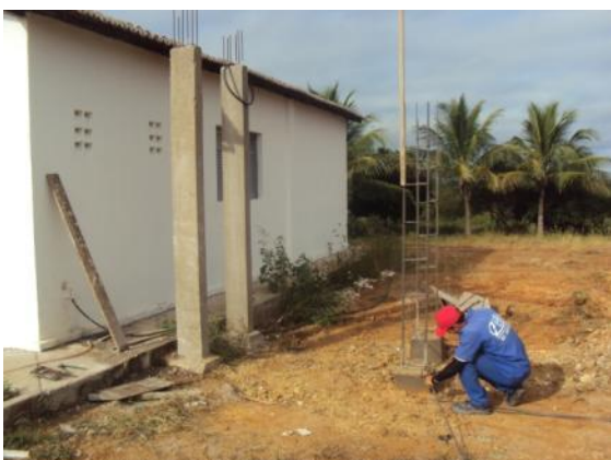
Figura 102: Armação de ferragens para concretagem de pilares
