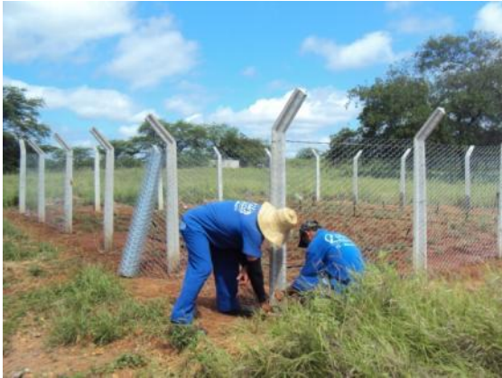
Figura 63: Instalação do telado
