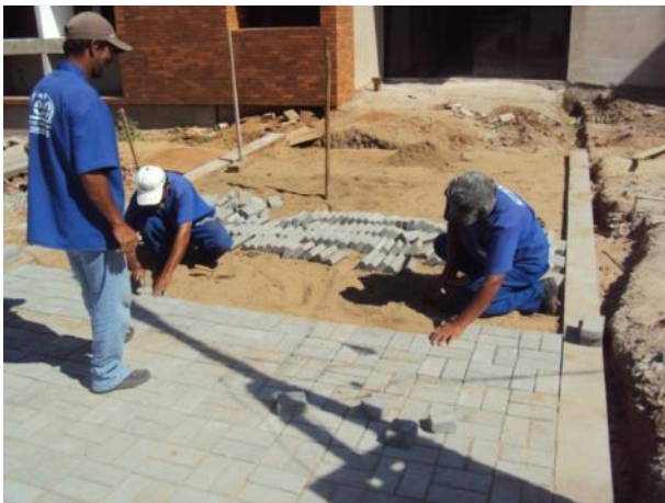
Figura 13: Assentamento dos PAVERS
