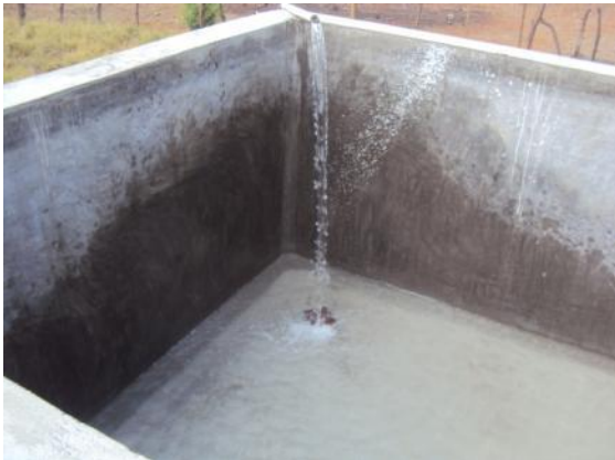
Figura 81: Reservatório de água acabado
