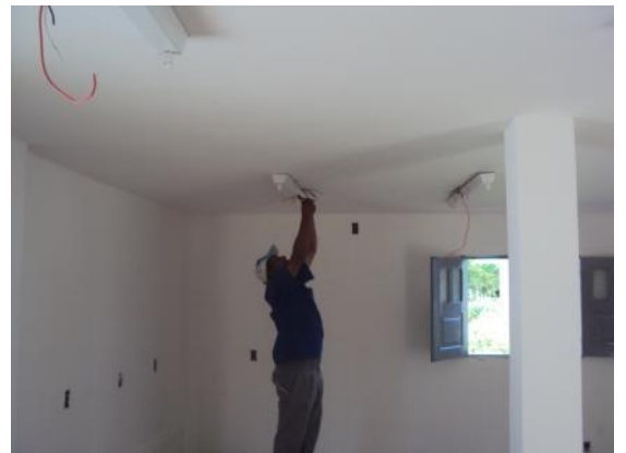
Figura 18: Instalação de luminárias
