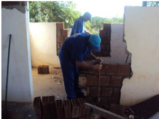
Figura 123: Construção de alvenaria de tijolos cerâmicos
