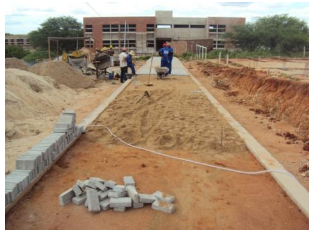
Figura 12: Colchão de areia para assentamento dos PAVERS
