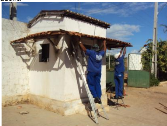
Figura 3: Assentamento das telhas cerâmicas
