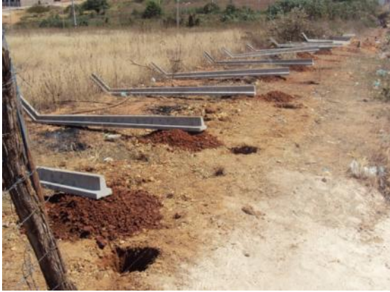
Figura 121: Escavação e assentamento de estacas de concreto
