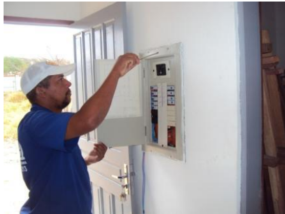
Figura 40: Trabalhos de instalações elétricas
