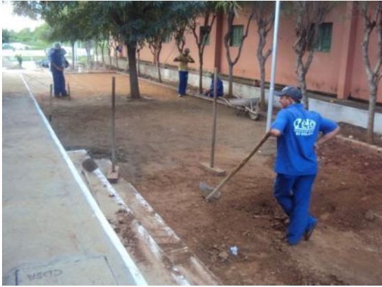
Figura 67: Compactação do material de aterro
