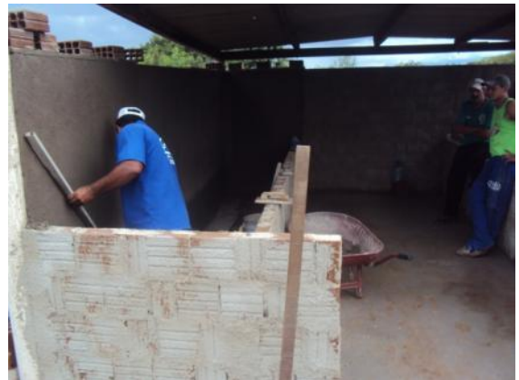
Figura 54: Trabalho de chapisco e reboco
