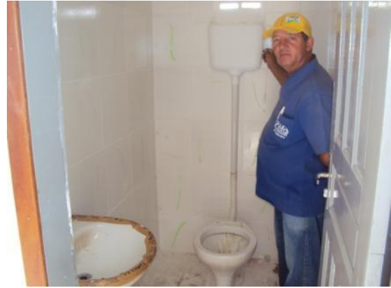
Figura 39: Assentamento de peças sanitárias
