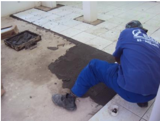
Figura 21: Assentamento de piso cerâmico
