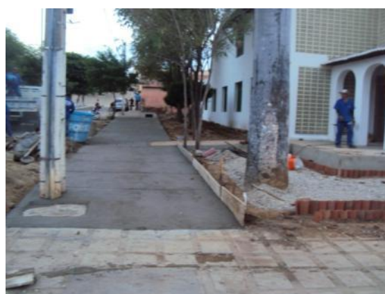
Figura 131: Concretagem de lastro de calçada
