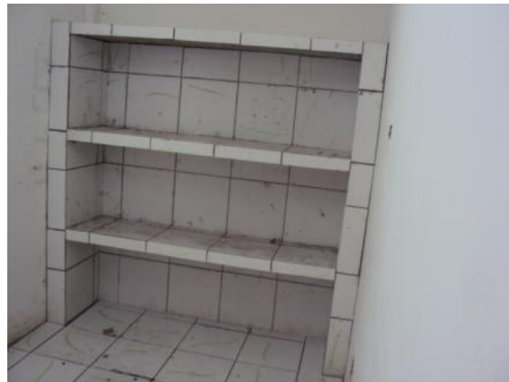
Figura 22: Prateleiras em concreto com revestimento cerâmico
