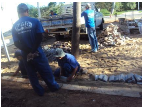
Figura 69: Assentamento de blocos intertravados PAVERS
