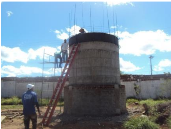
Figura 100: Concretagem do reservatório de água
