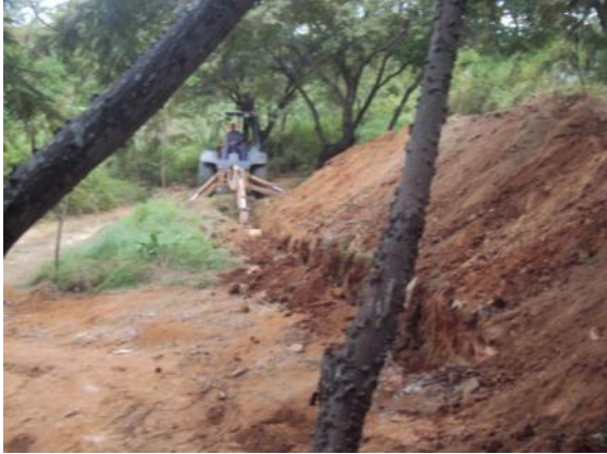
Figura 135: Escavação com máquinas pesadas
