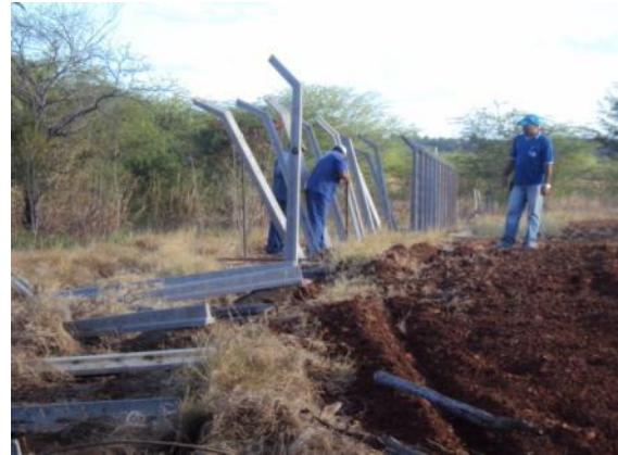
Figura 86: Construção de cerca com estacas de concreto
