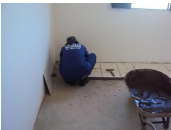
Figura 77: Assentamento de piso cerâmico em edificação existente no local
