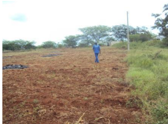
Figura 74: Limpeza e capina do terreno
