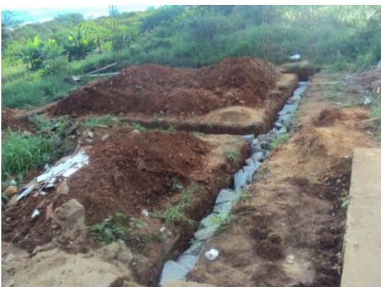
Figura 32: Fundação em pedra rachão
