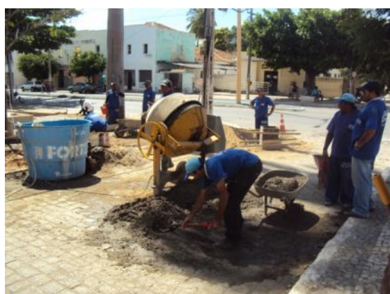
Figura 130: Concretagem de lastro de calçadas
