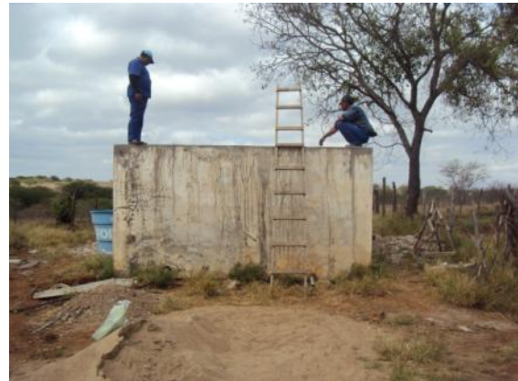
Figura 82: Reservatório de água acabado
