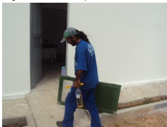
Figura 37: Janelas a serem assentadas no edifício
