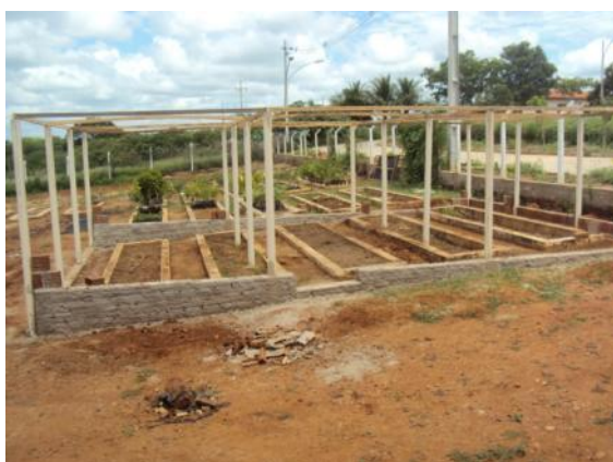
Figura 25: Estrutura em alvenaria e superestrutura em concreto
