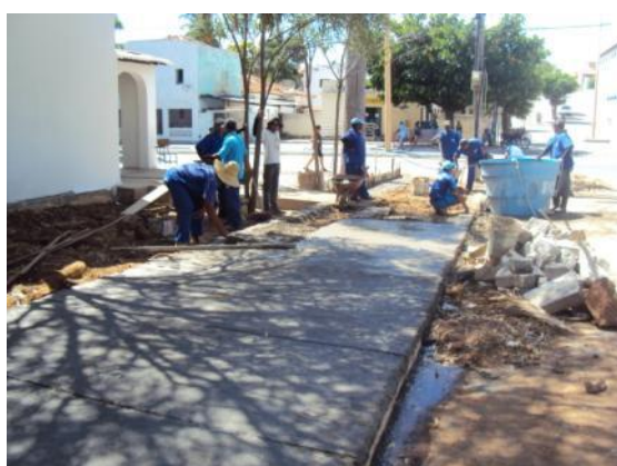
Figura 129: Concretagem de lastro de calçadas
