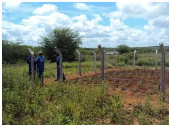
Figura 62: Fixação de arames para posterior instalação do telado
