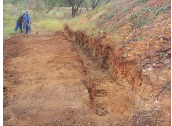
Figura 136: Limpeza do terreno
