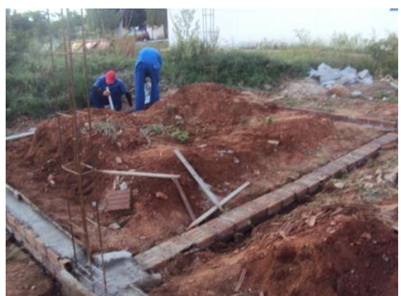
Figura 33: Início da construção da alvenaria em tijolos cerâmicos e armação das ferragens da superestrutura
