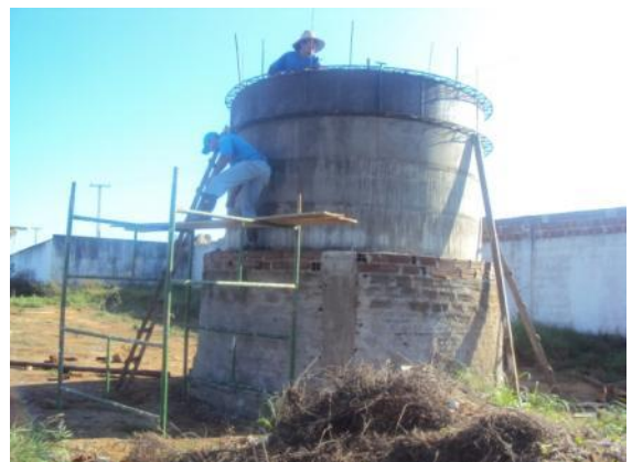
Figura 99: Concretagem do reservatório de água
