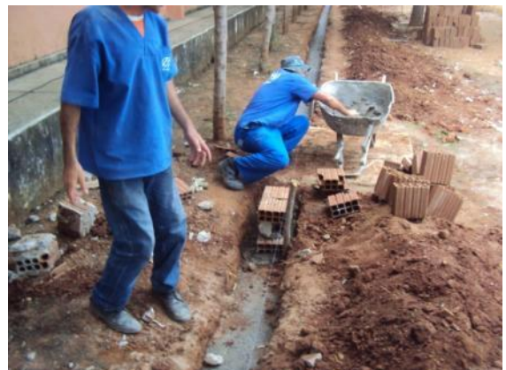
Figura 66: Construção de alicerce para PAVERS
