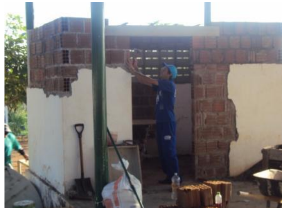
Figura 124: Construção de alvenaria e cobogó
