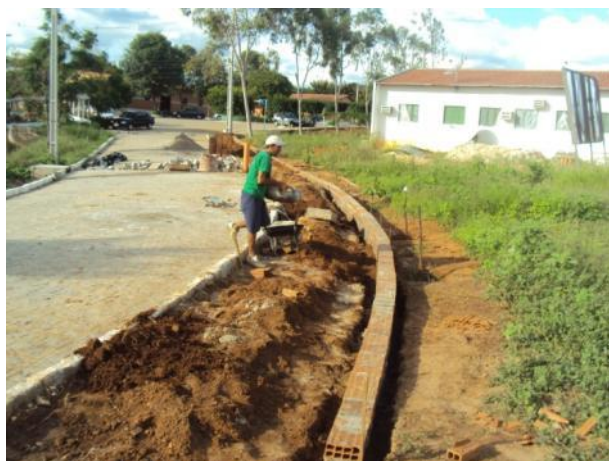
Figura 6: Construção do alicerce e reaterro do caixão
