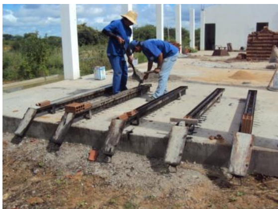
Figura 117: Construção de estacas de concreto
