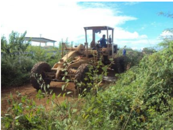
Figura 49: Limpeza do terreno e regularização com uso de máquinas pesadas
