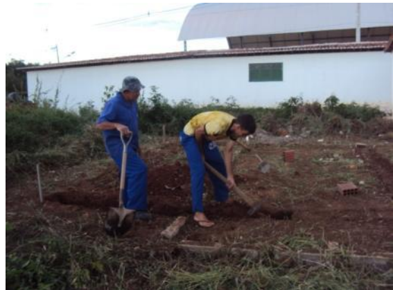
Figura 31: Escavação para construção de alicerce
