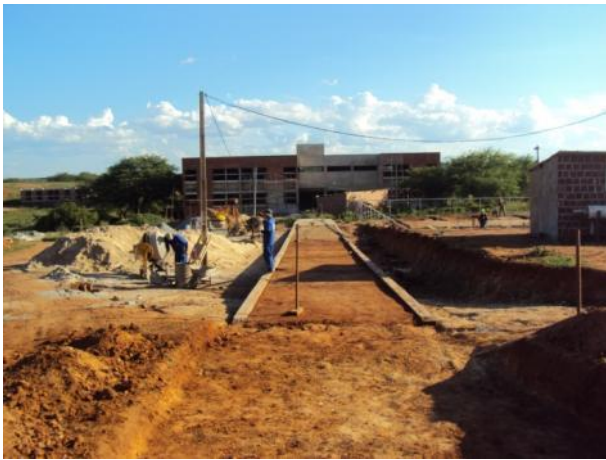
Figura 11: Compactação do material de aterro
