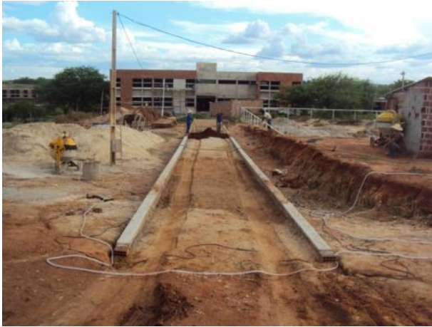
Figura 9: Construção das muretas de contenção dos PAVERS
