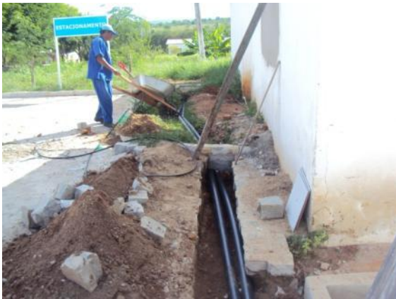
Figura 15: Assentamento de tubos para instalações elétricas
