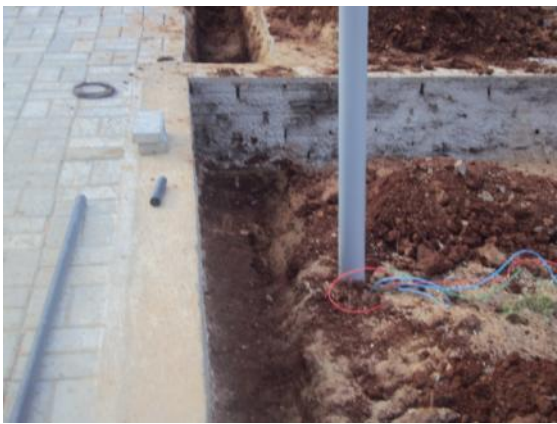
Figura 112: Trabalho de instalações elétricas
