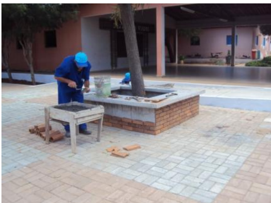
Figura 71: Construção de bancos em concreto armado
