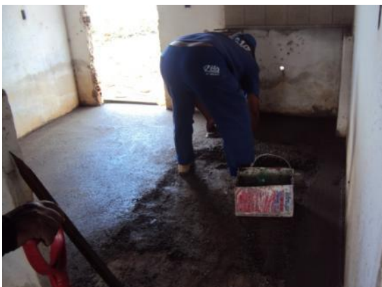
Figura 83: Reforma de piso em edificação existente no local
