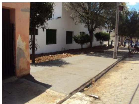
Figura 128: Pintura de fachadas e construção de calçadas adjacentes
