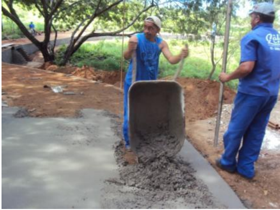
Figura 47: Concretagem do lastro da calçada
