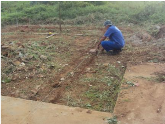
Figura 30: Locação da obra
