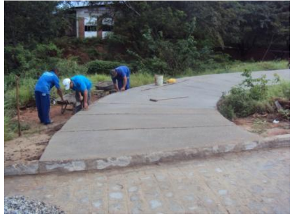
Figura 48: Obra da passarela acabada
