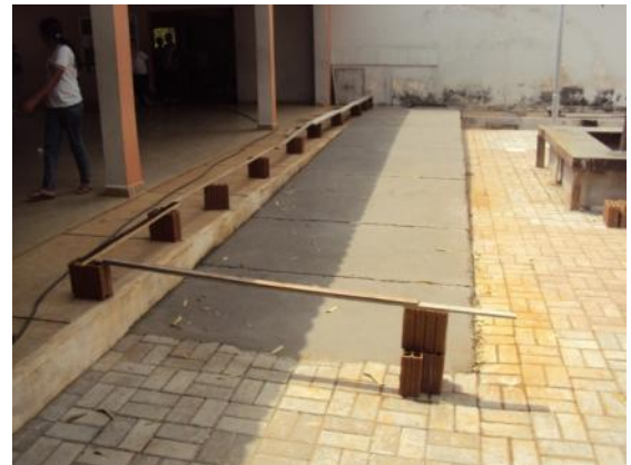
Figura 72: Construção de rampas e calçadas
