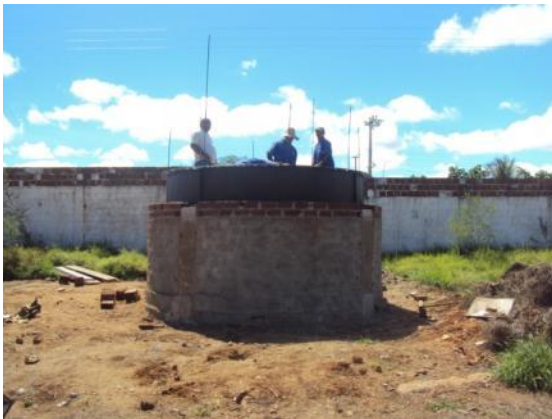
Figura 96: Início concretagem do reservatório de água
