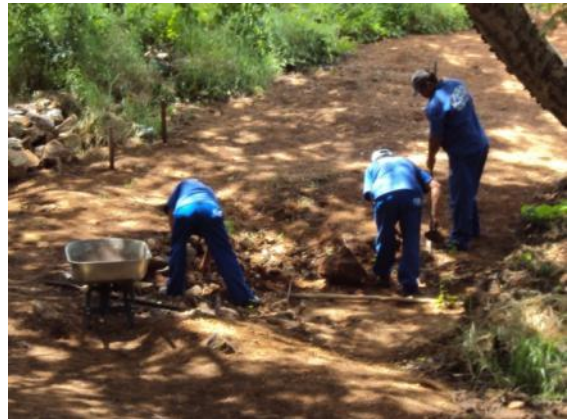
Figura 42: Limpeza do terreno e remoção de entulhos
