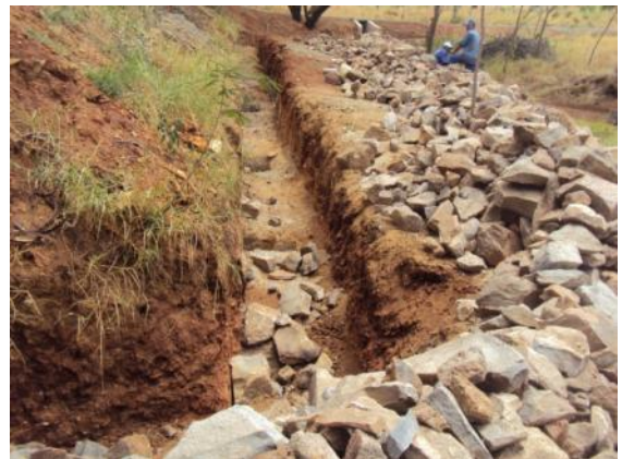
Figura 138: Utilização de pedração rachão no alicerce do muro de arrimo
