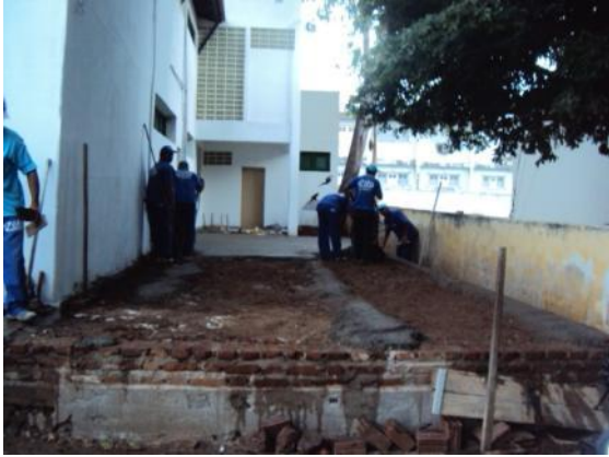
Figura 132: Cconcretagem de calçada interna à área do edifício
