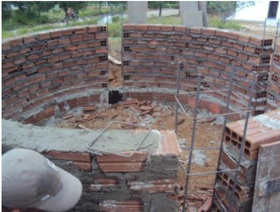
Figura 94: alvenaria em tijolos cerâmicos base para reservatório de água
