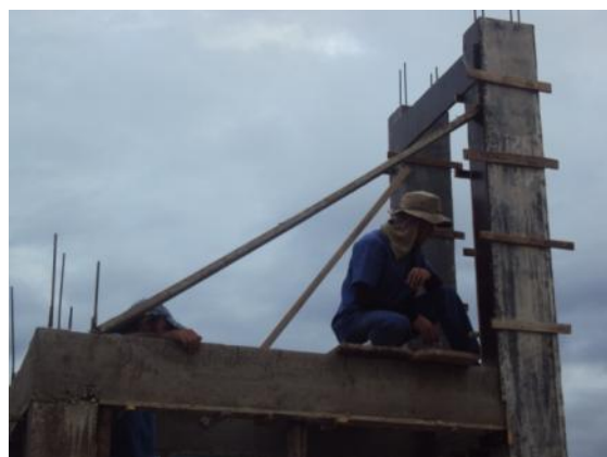
Figura 103: Concretagem de pilares e vigas do reservatório
