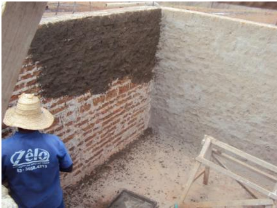
Figura 79: Chapisco em reservatório de água
