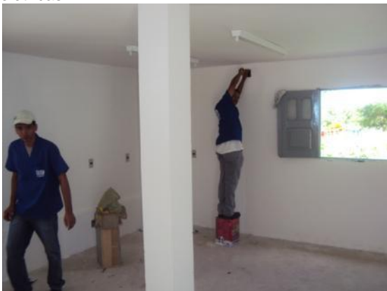
Figura 17: Trabalhos de emassamento e pintura
