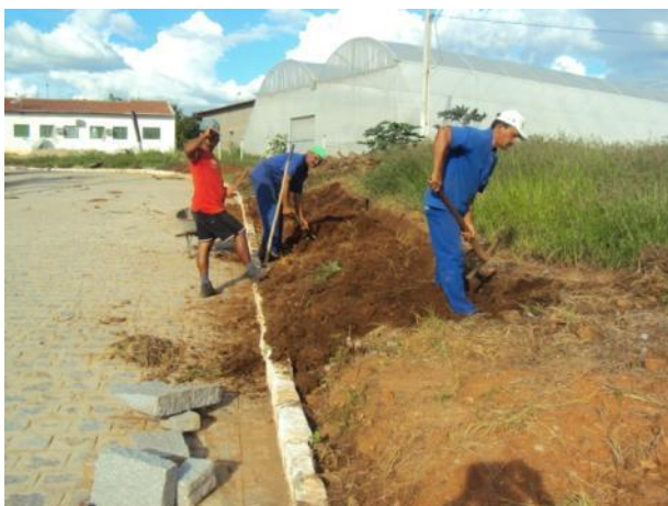
Figura 5: Escavação para construção de calçada
