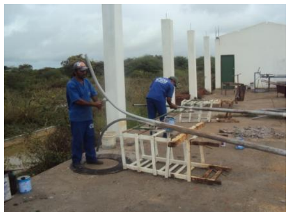
Figura 109: Pintura dos postes de aço para iluminação
