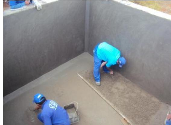
Figura 80: Reboco em reservatório de água
