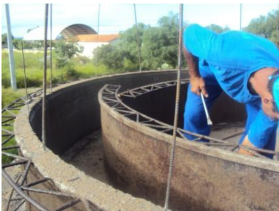
Figura 98: Desforma da concretagem
