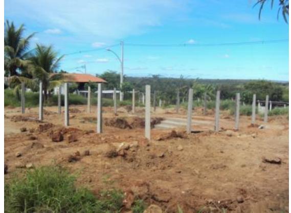
Figura 58: Assentamento de estacas para fixação de telado
