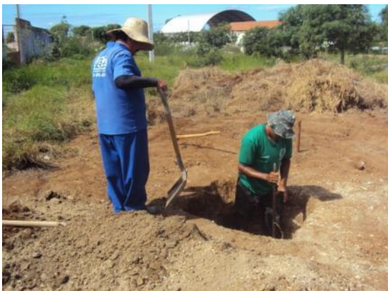
Figura 92: Escavação para construção de alicerce
