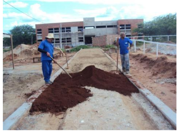
Figura 10: Reaterro do caixão
