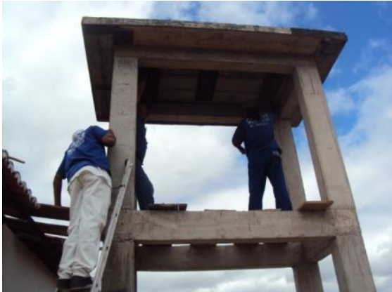
Figura 104: Construção de laje para assentamento de reservatório de água
