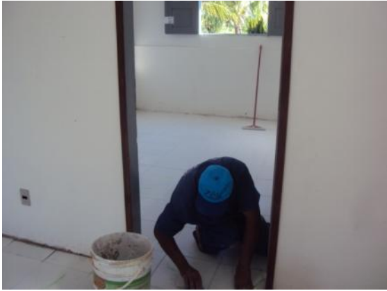
Figura 38: Assentamento de piso cerâmico
